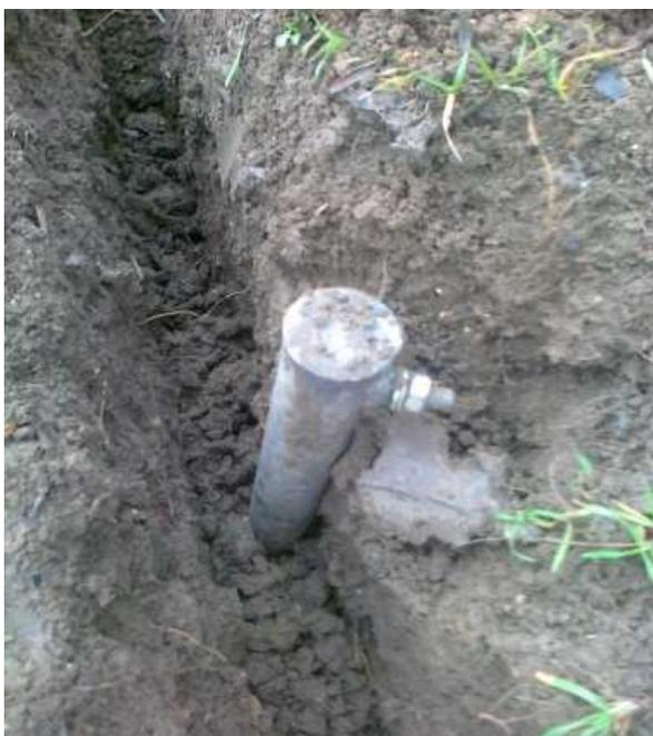
Fig.3. Rod electrode.
